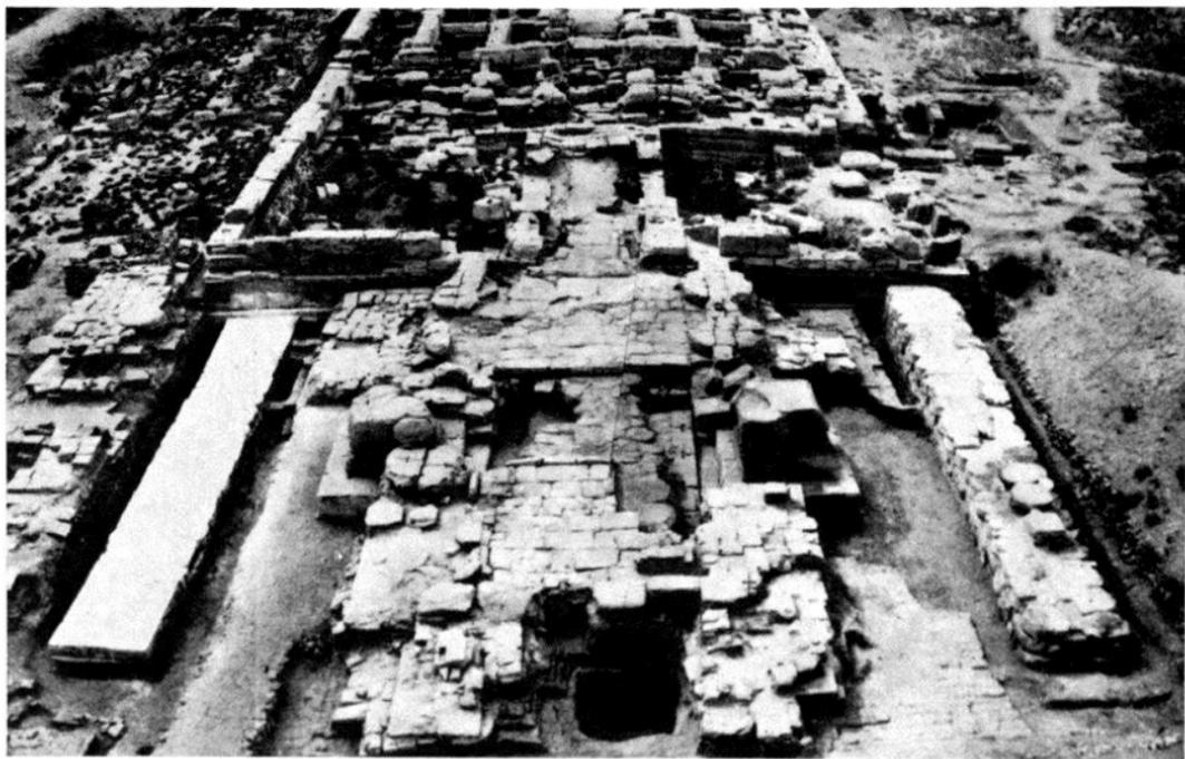
Fig. 23. Karnak-Nord. Plateforme antérieure du temple de Montou; vue prise du Nord, grande porte de Ptolémée IV. Mars 1950. Entre les soubassements centraux, qui englobent les bases d'obélisques, le dallage, coupé, laisse apparaître les restes de la chaussée du granit rouge. Le soubassement latéral Ouest a été seulement nettoyé. Le soubassement Est est en cours de démontage. La III<sup>e</sup> assise apparaît décapée.
