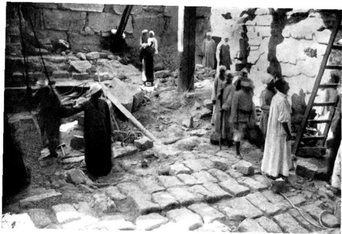
Fig. 7. Karnak. Grand temple d'Amon. Travaux de démontage du II<sup>e</sup> pylône.
