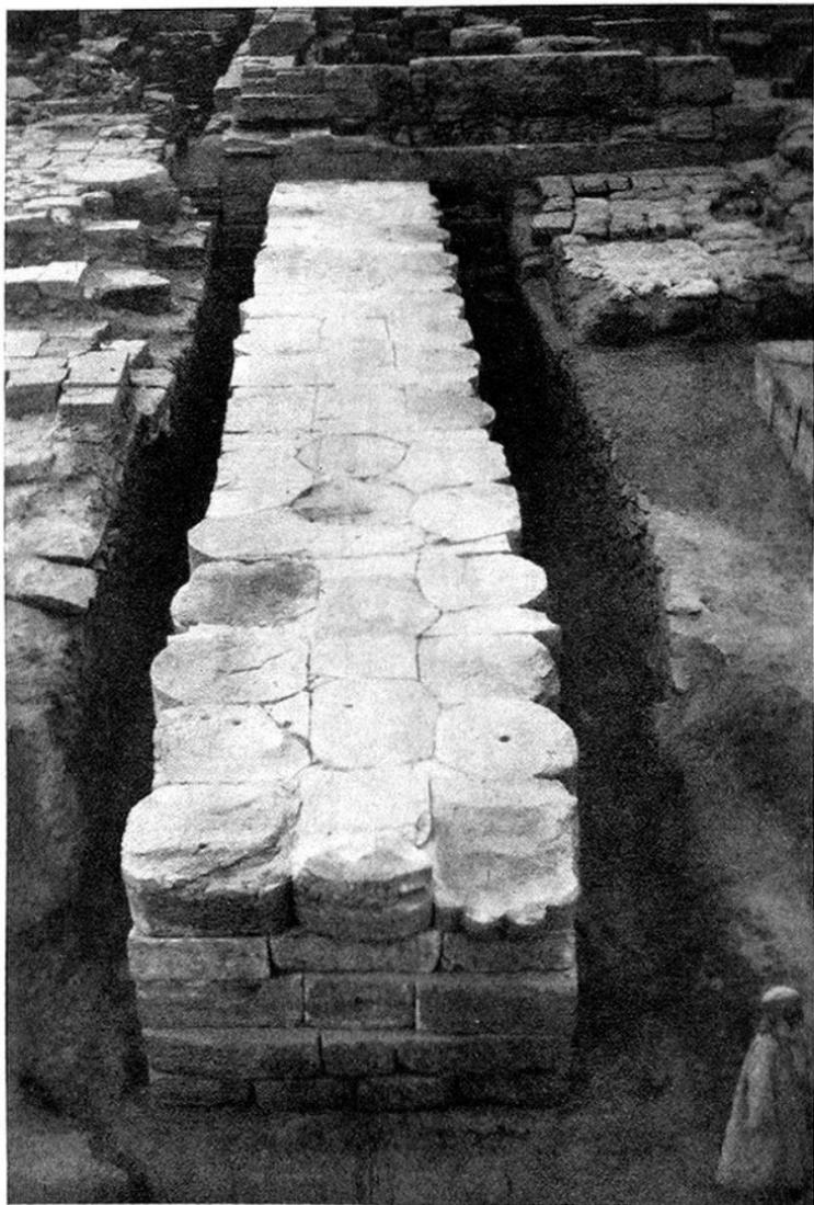
Fig. 22. Karnak-Nord. Soubassement Est de la plateforme antérieure de Montou. Les cinq assises de blocs remployés. Remarquer la simplicité géométrique du plan supérieur de la V<sup>e</sup> assise.
