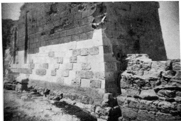
Fig. 14. Abousir (Taposiris Magna). Consolidation du massif Nord du pylône d'entrée de la grande enceinte du temple.
