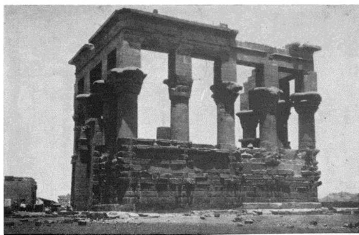
Fig. 2. Philae, kiosque de Trajan, en 1948, après les restaurations. Vue prise du Sud.
