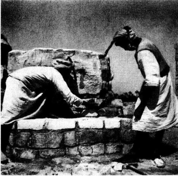
Fig. 35. – Soleb. Travail de mise en place des éléments d'un tambour A, sur une base reconstituée. On remarquera sur la tête des maçons les mèches à combustion lente destinées à repousser les *nimitti*.
