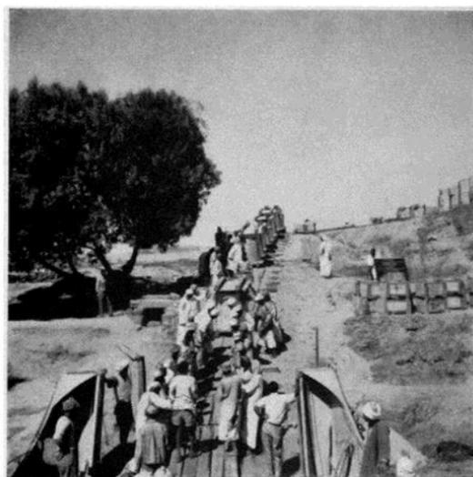
Fig. 28 et 29. - Démontage du temple de Buhen.
