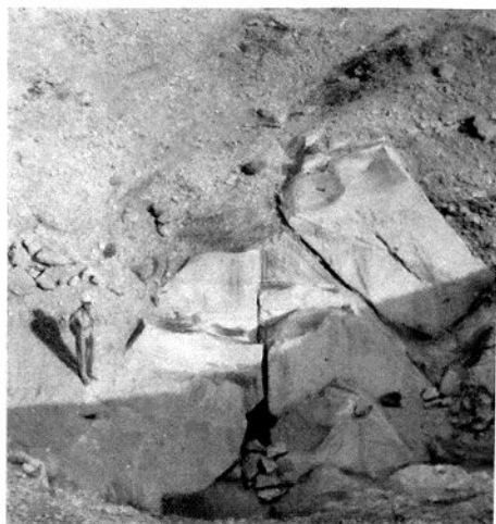
Fig. 15 et 16. – Saqqarah-Sud. Dégagement de l'accès à la partie supérieure de la chambre sépulcrale de Pépi I er . On notera les énormes dalles disposées en chevrons.
