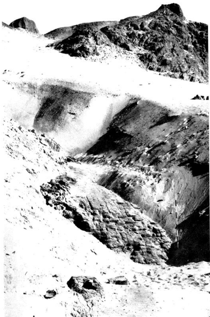
Fig. 47. — Mirgissa. Fortifications au pied de la forteresse: couloir de circulation soutenu par un appareil massif de briques crues.
