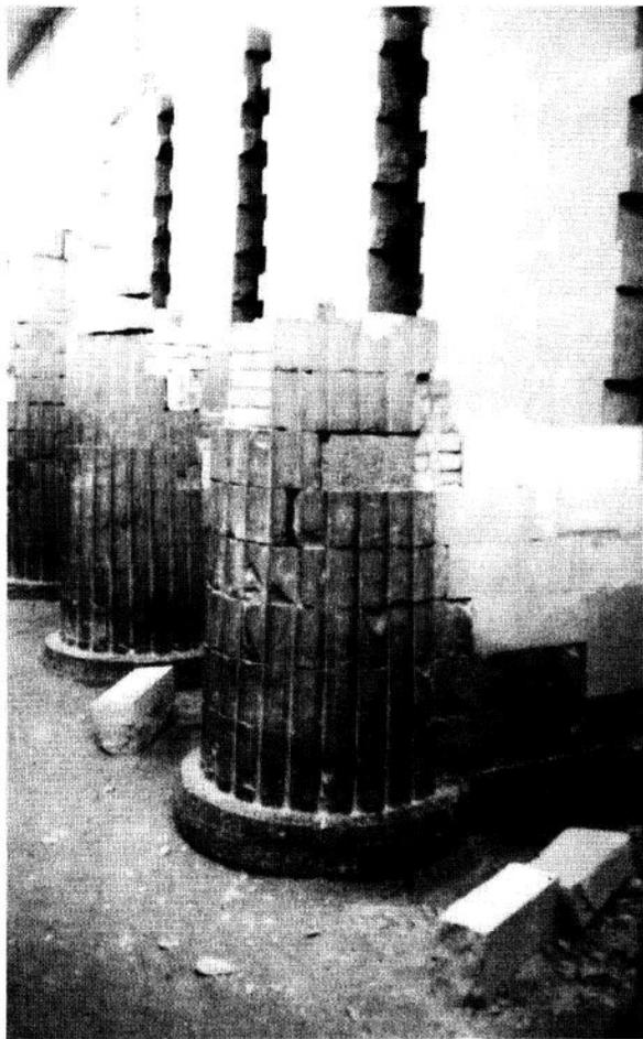
Fig. 17 - Saqqarah. Complexe de Djéser. Rangée Nord des colonnes de l'extrémité orientale du hall d'entrée, avec les hautes brèches verticales laissées en vue du raccordement des piles d'appui des colonnes.
