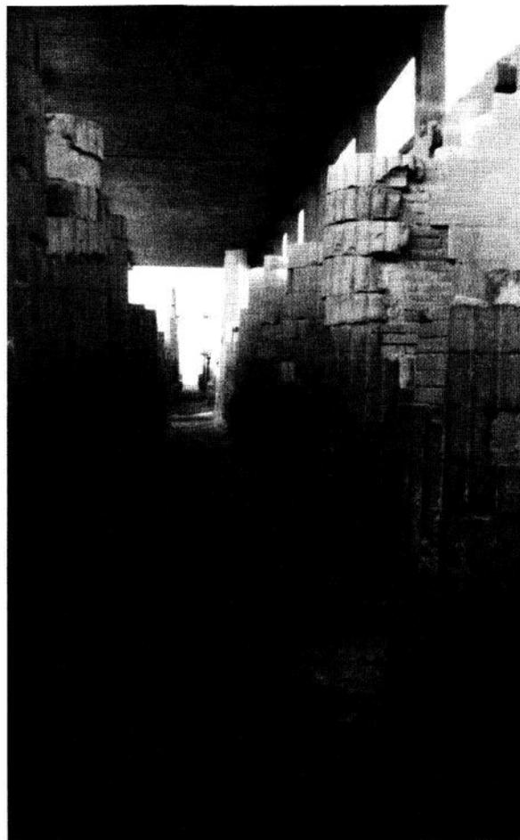
Fig. 18 - Saqqarah. Complexe de Djéser. La même rangée de colonnes après anastylose partielle et reconstitution des piles d'appui comblant ces brèches.
