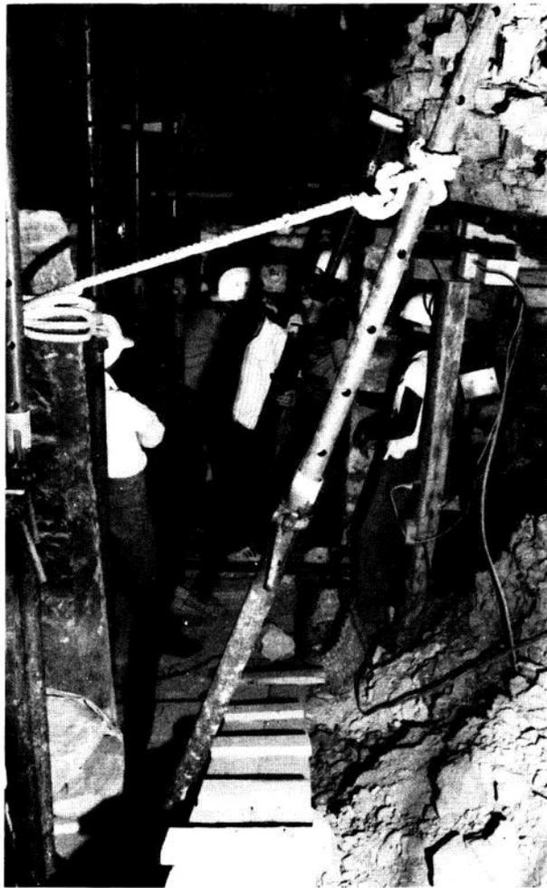
Fig. 33 - Saqqarah. Tombe d'Âperia. Les travaux de réfection et de soutènement de la chambre 24.
