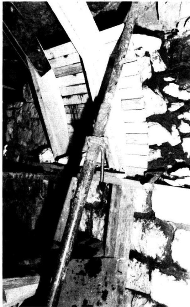
Fig. 34 - Saqqarah. Tombe d'Âperia. Détail d'une voûte de soutènement en maçonnerie (chambre 24), avec son support provisoire en bois.
