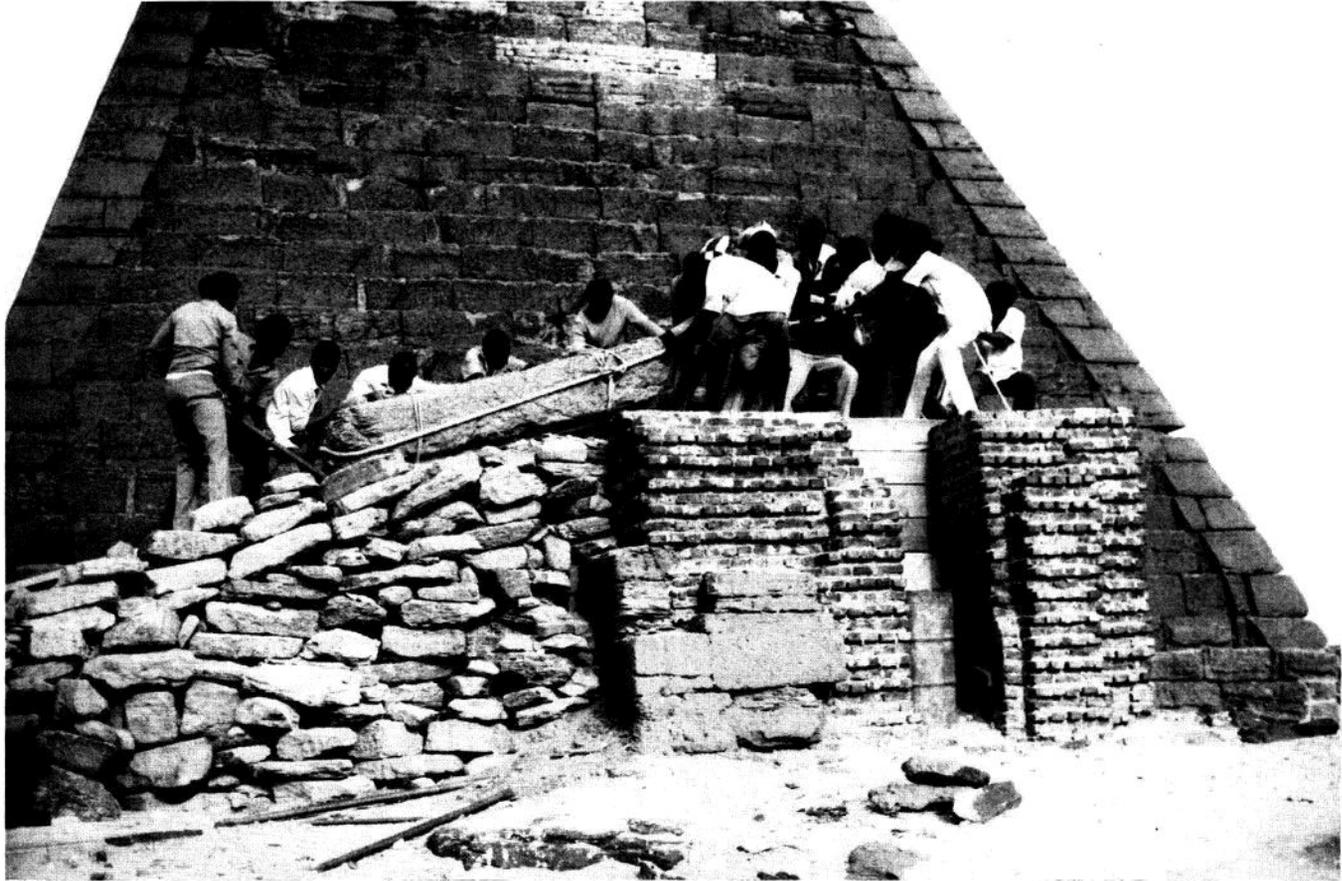
Fig. 76 - Méroé. Pyramide Bég. N 21. Remise en place d'une dalle du toit de la chapelle pesant près de deux tonnes.
