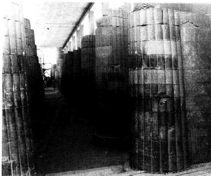
Fig. 20 - Saqqarah. Complexe funéraire de Djéser. Reconstitution de la pile d'appui de la première colonne, dans la rangée Nord de la colonnade d'entrée.
