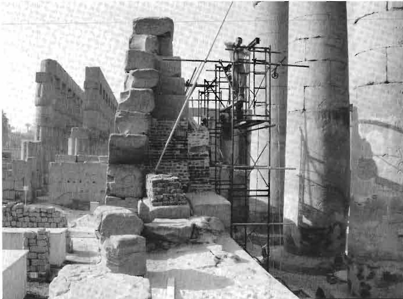
Fig. 33 – Louqsor: remise en place des blocs (cliché de la Mission).
